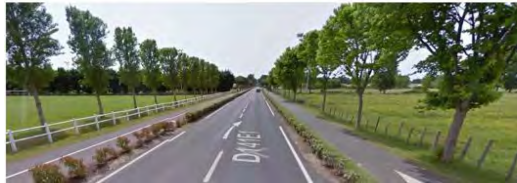
Figure 166 : Site propre le long de la RD141E1
