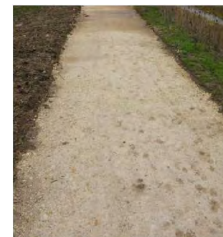
Figure 209 : Revêtement en calcaire
