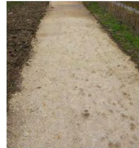
Figure 188 : Revêtement en calcaire
